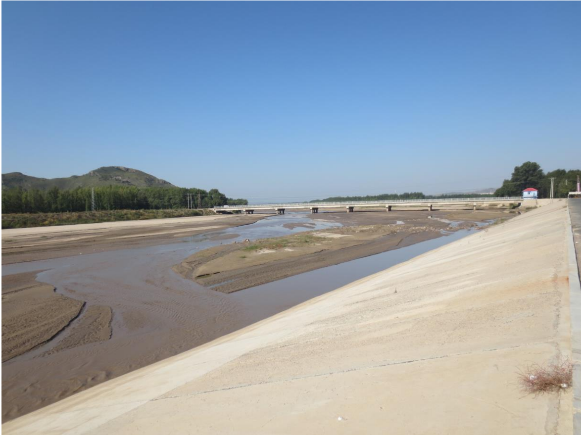
大板南桥下游河道情况
